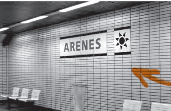
Signalétique en station
