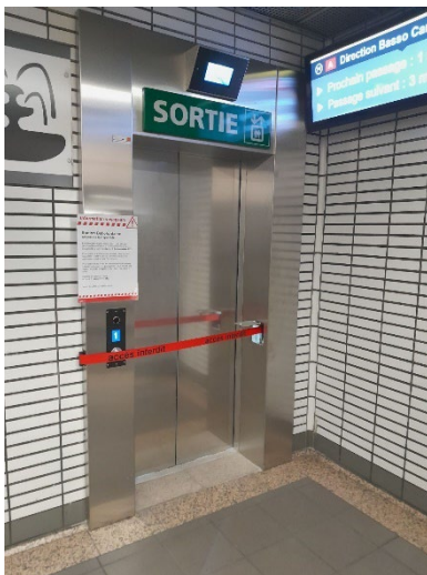
Elargissement de la porte
