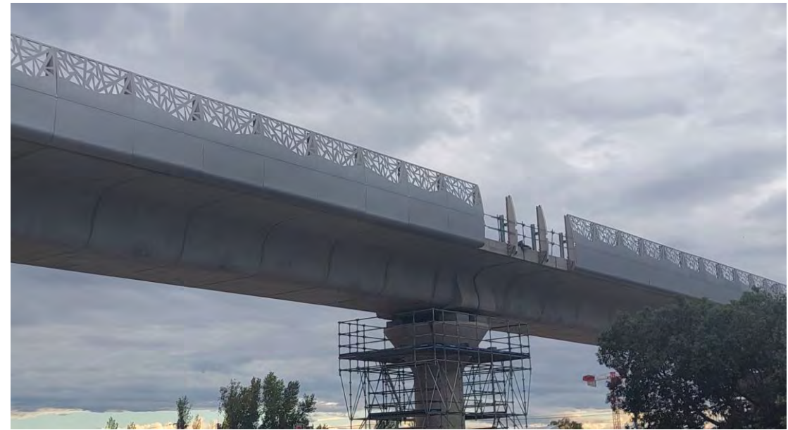
Corniches posées sur viaduc dans le secteur La Cadène
